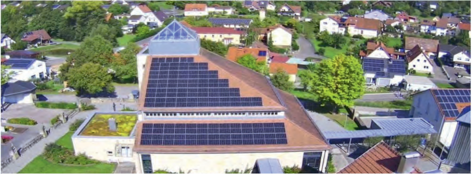
Foto: Florian Bauer, Blick von oben auf die Photovoltaikanlage auf dem Dach der Kirche Sankt Bartholomäus. Die Solarmodule belegen eine Fläche von insgesamt rund 140 Quadratmetern.
