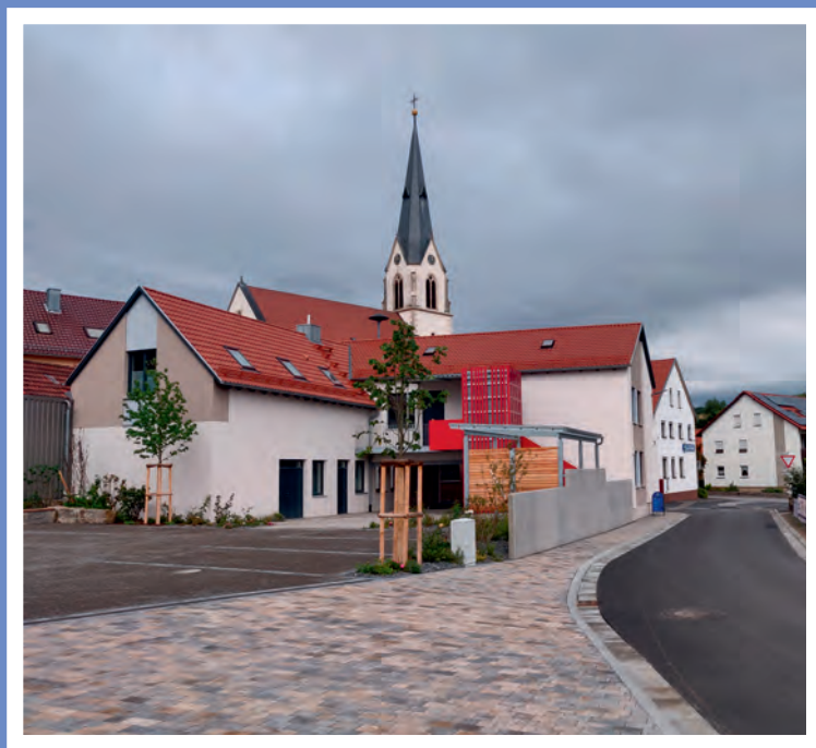
Sanierung Ebersbacher Straße vor dem Gemeinschaftshaus Windhausen
