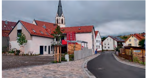
Fertiggestellt: Ebersbacher Straße im Bereich des Gemeinschaftshauses
