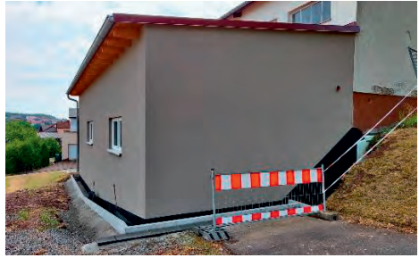
Verbesserung der Isolierung am Anbau und an der Giebelseite des Feuerwehrhauses
