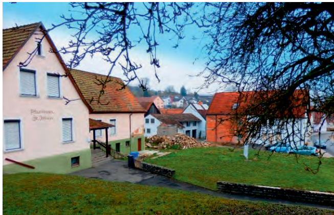
Nach dem Abriss des Pfarrheims entsteht hier eine große Baufläche, die für Sonderzwecke genutzt und ansprechend gestaltet werden soll.
