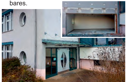
Die Schultüre und das Vordach wurden sorgfältig abgebaut und eingelagert. Sie können für das neue Rathaus verwendet werden. Die Maße passen zufällig ganz genau. Das spart viel Geld!
