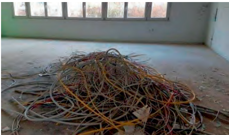
Für den gesamten Abbruch gilt: Strenge Trennung der verschiedenen Materialien.
