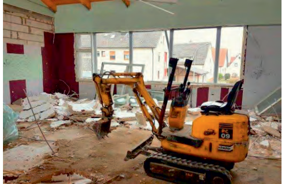
Die Abrissarbeiten begannen im Inneren des Gebäudes. Hier entfernt ein Kleinbagger den Estrich.
