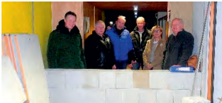
Mitglieder des Bauausschusses besichtigten die Trennmauern in den Fluren der Schule
