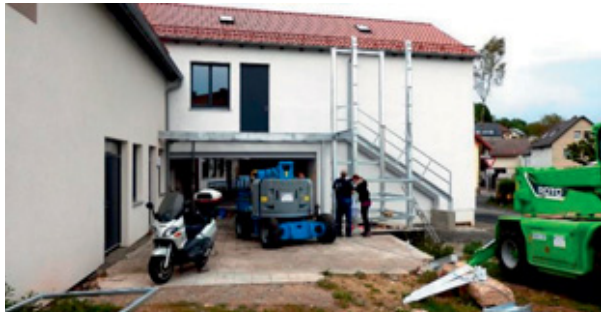
Montage der Außentreppe und des Rahmens für die Hebeplattform (Lift)
