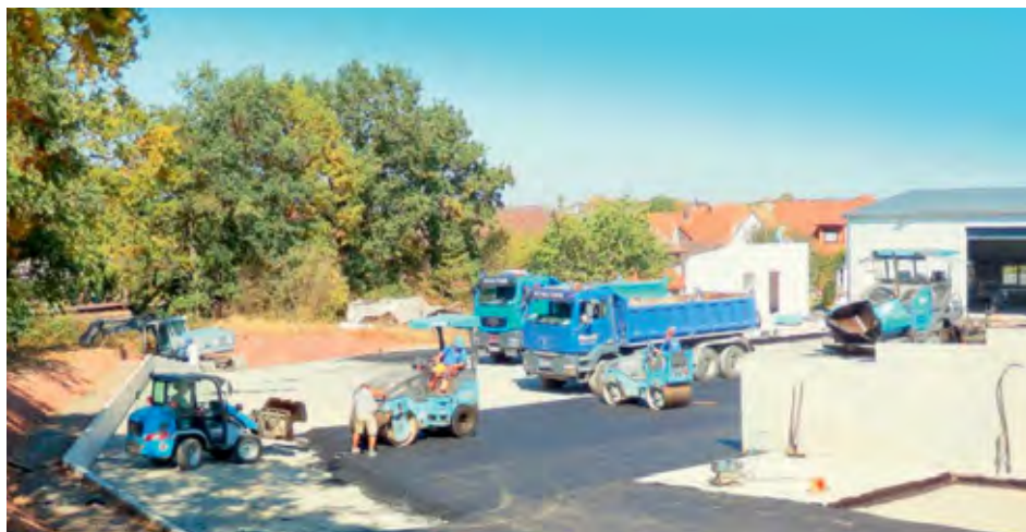
Aufbringen der Schwarzdecke im Betriebshof. Rechts im Bild die Schüttgutboxen
