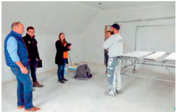
Guter Baufortschritt. Hier: Musik-Proberaum mit den gerade frisch angebrachten Schalldämmplatten
