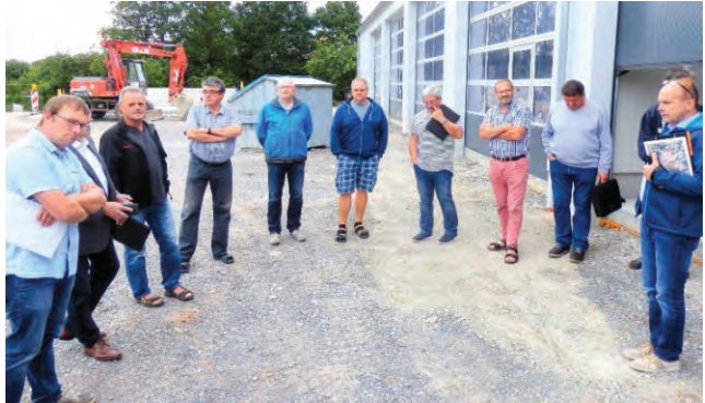
Mitglieder der Verbandsversammlung besichtigen den Baufortschritt
