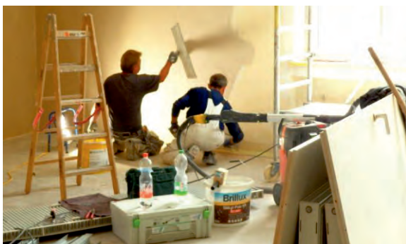
Schwerpunkt Innenausbau. Hier: Verputzarbeiten im großen Versammlungsraum
