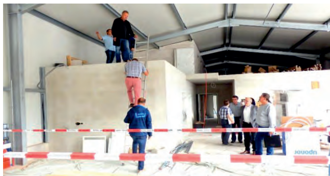
Mitglieder der Bauhofgemeinschaft bei der Besichtigung der Hallen Hier: Einbauten für die Büroräume
