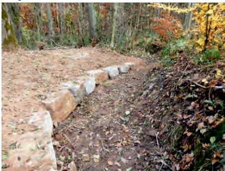
Beobachtungstümpel mit einem befestigten Ufer. Die trockene Witterung war für die Bauarbeiten von großem Vorteil!
