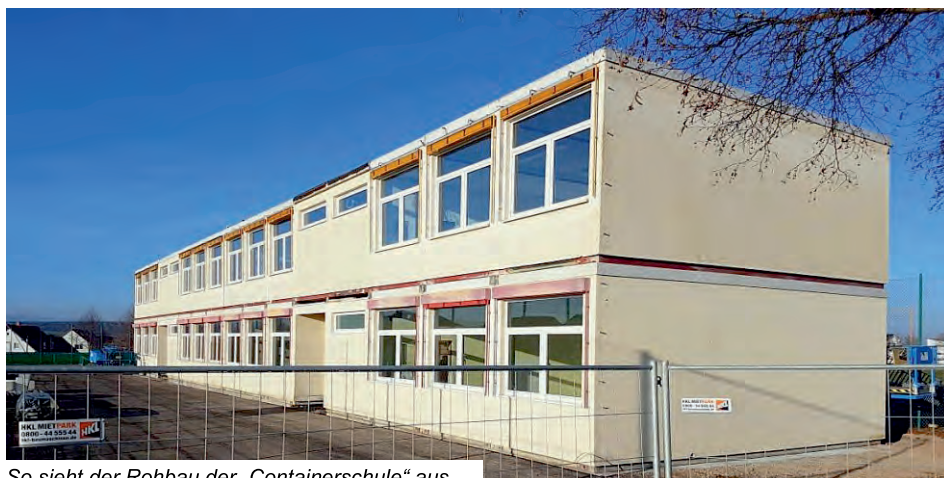
So sieht der Rohbau der „Containerschule“ aus.
