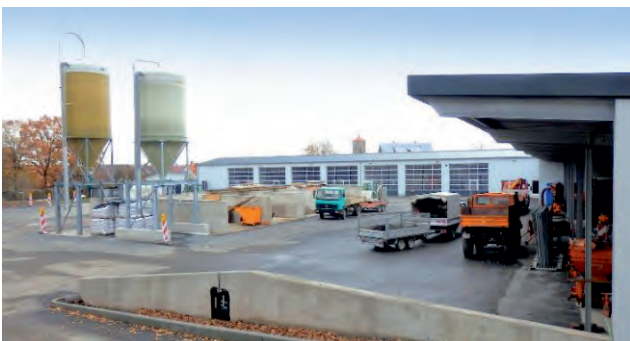
Links die Salzsilos, daneben die Schüttgutboxen, dahinter das lange Gebäude mit den Werkstätten und Lagerräumen, den Büros und Sozialräumen, rechts die Unterstellhalle für Fahrzeuge, Maschinen und Geräte
