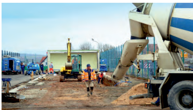
Rechts im Bild: Arbeiter der Bauhofgemeinschaft erstellen den Versorgungsgraben
