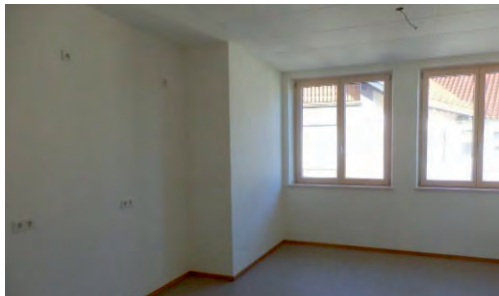
Deutlich größer: Ein echter Gewinn ist der neue Küchenraum im Obergeschoss. Links vorne im Bild in der Nische ist Platz für die Küchenzeile
