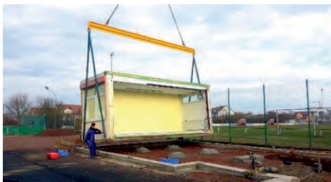
Start! Der erste Container ist am Haken
