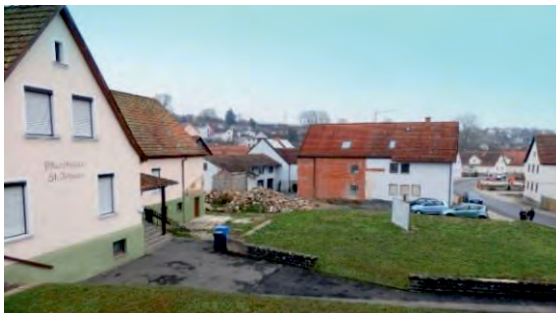
Hier sollen barrierefreie Wohnungen und eine Tagespflege entstehen
