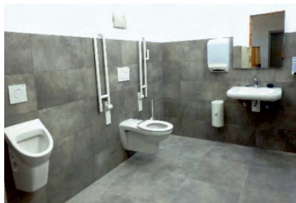
Eine echte Verbesserung: Das großräumige barrierefreie WC im Obergeschoss
