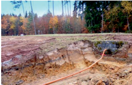
Wassereinlauf. Hier soll ein Wassertretbecken eingerichtet werden
