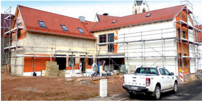
Gemeinschaftshaus Windshausen. Die Fassadendämmung ist gut vorangekommen. Deutlich sichtbar der neue Zugang über die Außentreppe und die Hebeplattform (Lift).
