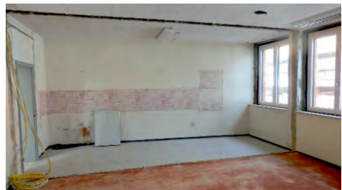
Geplante Vergrößerung der Küche. Zwischenwand zum ehem. Bürgermeisterzimmer bereits entfernt.
