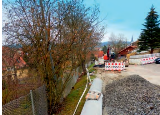
Baubeginn im Bauabschnitt 2 der Weinbergstraße in Windshausen
