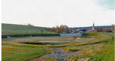
Rückhaltebecken in Richtung Burgwallbach
