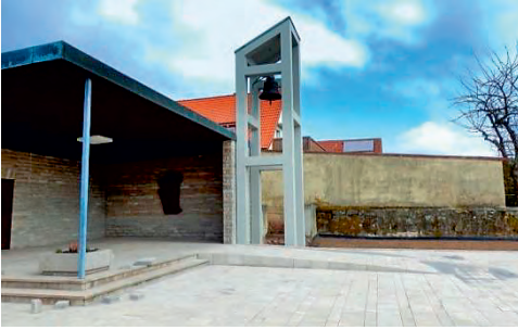
Neues Pflaster mit Rampe zur Leichenhalle
