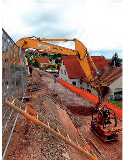
Stufenweiser Aufbau der Böschung. Lagerweises Aufbringen von geeignetem Boden und Verdichten der Schichten mit Walze und Rüttelplatte.
