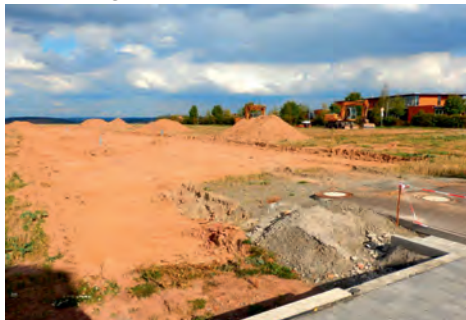
Hier geht's demnächst weiter! Landwehr, Bauabschnitt III. Abtrag von Mutterboden im Bereich künftiger Straßen
