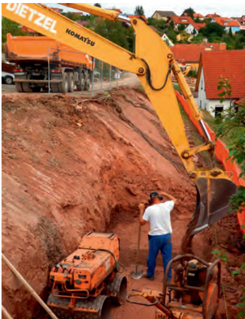
Stabile Gründung der Böschung auf verwitterten, aber festen Tongestein
