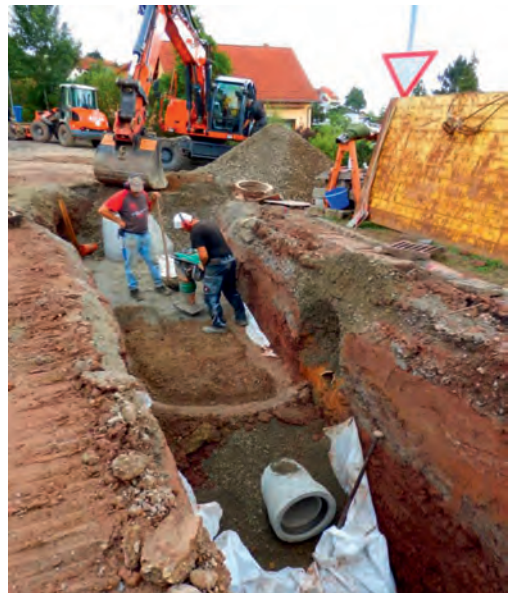
Fachgerechter Einbau des Kanals, Verfüllung mit geeignetem Material und gründliche Verdichtung
