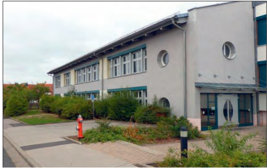
Dieser Gebäudeteil soll erhalten bleiben und saniert werden. Dahinter ist ein Neubau mit Verbindungstrakt geplant.
